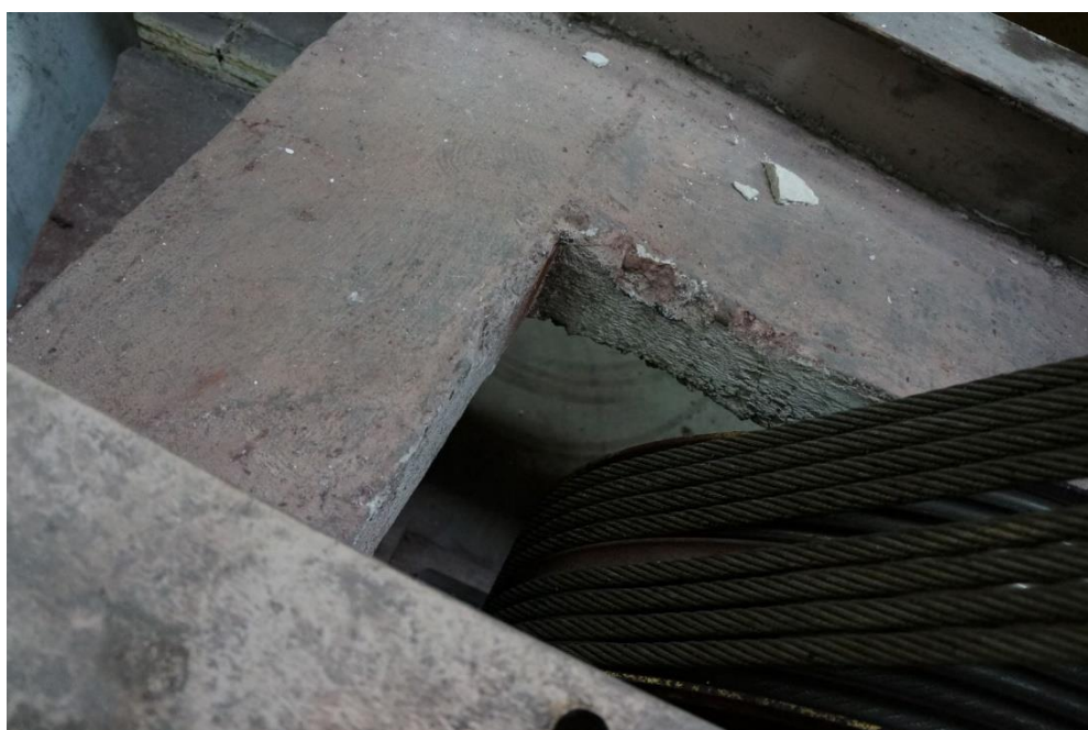
Rysunek 7. Płyta balastowa na belkach nośnych I260
