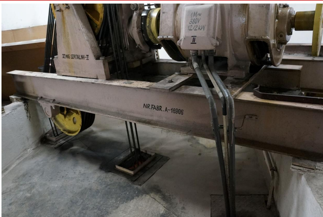
Rysunek 12. Rysa na posadzce - jednostka dźwigowa nr 2 –
