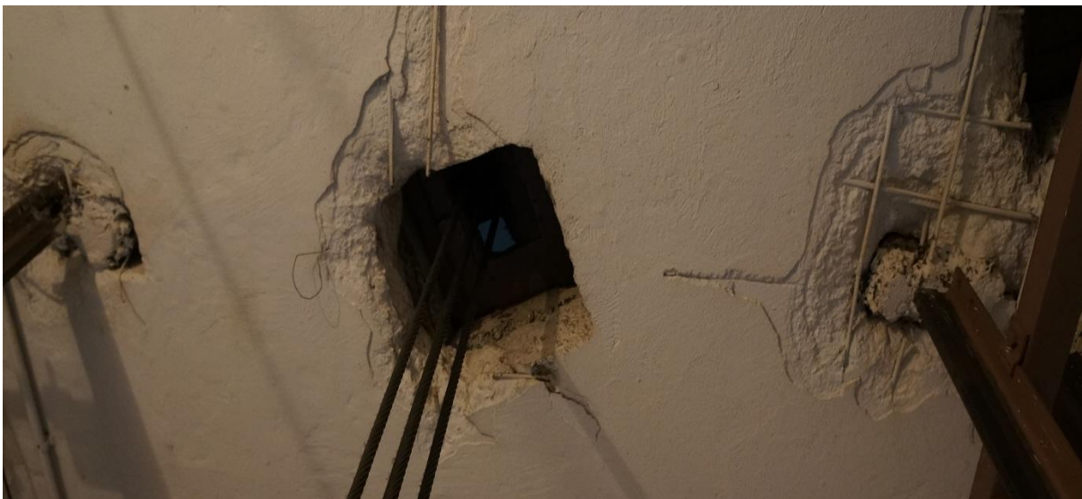
Rysunek 10. Układ zbrojenia w stropie nadszybia.
