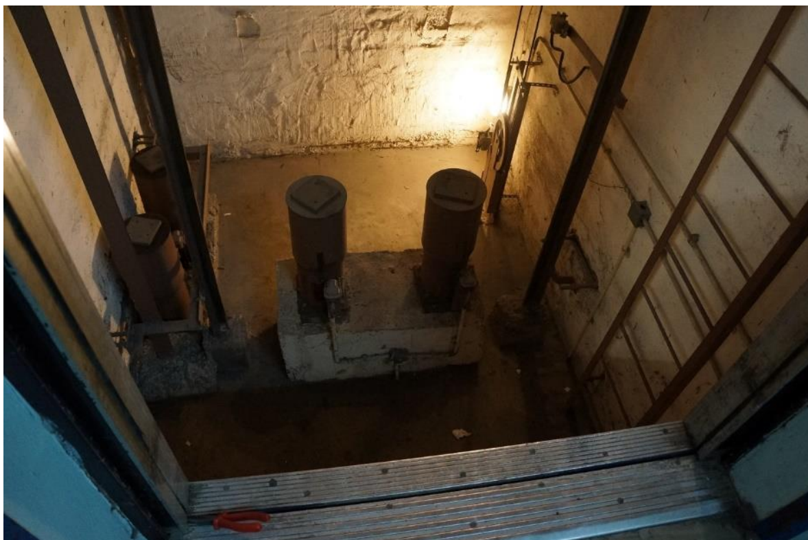
Rysunek 5. Podszynie W środkowej części dwa zderzaki kabiny , po lewej stronie 2x zderzaki przeciwwagi
