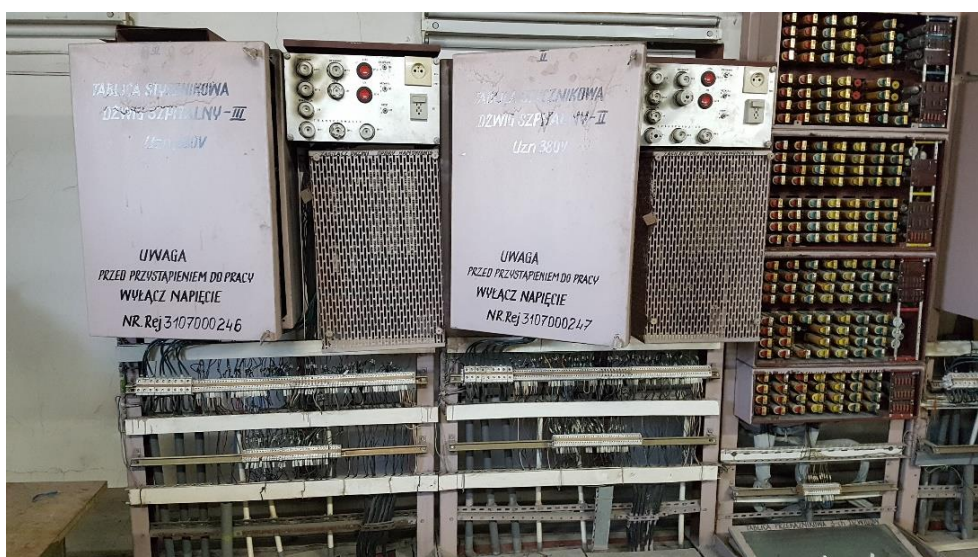
Rysunek 17. Szafy sterownicze w maszynowni trzech wind
